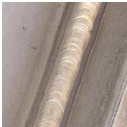
PB TIG (141) - spoina pachwinowa, austenityczna stal nierdzewna o grubości 3 mm, gaz osłonowy Inolinx® TIG.
